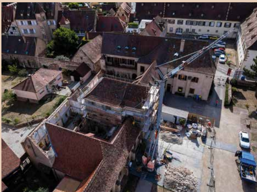
La cour de la Chartreuse a véritablement changé de visage. Une grue est désormais installée devant l'ancienne bibliothèque. Avant la dépose de la toiture, l'intérieur est entièrement évidé.
