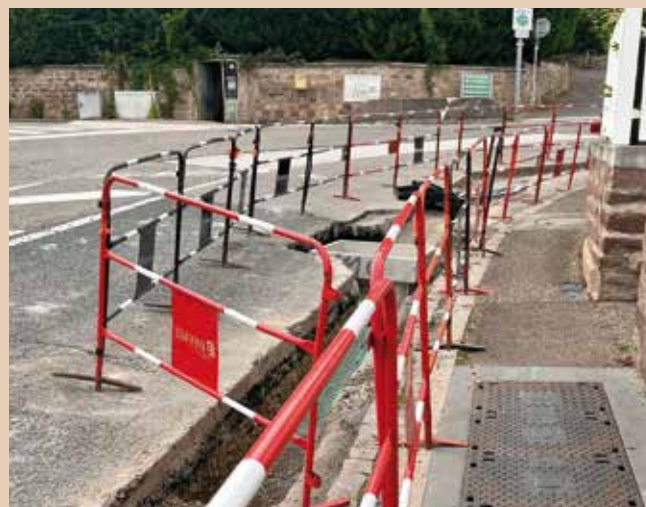
Courant mai, des fourreaux ont été posés en tranchée sur la rue de Saverne pour permettre le raccordement des câbles et du panneau électronique à la fibre.
