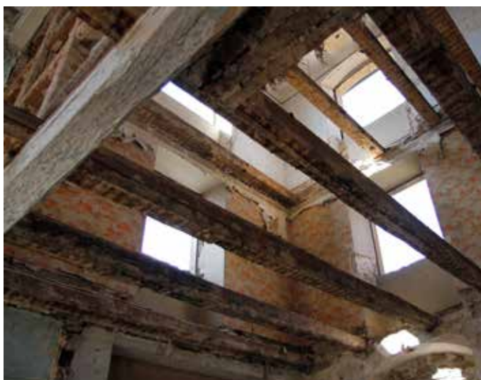
Cette vue de l'intérieur de l'ancienne bibliothèque de la Chartreuse permet d'entrevoir les différents niveaux de la structure. Une fois rénovée, elle sera aménagée en pièce cathédrale et accueillera la Grande Croix des Chartreux.
