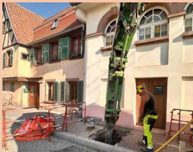
Le 8 juillet, les techniciens mandatés par Barr énergies travaillaient au niveau de la rue du Maréchal Kellermann. Les sous-bassements en béton freinent quelque peu l'avancement du chantier.
