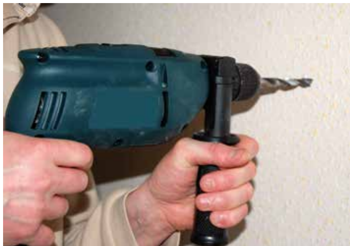
Avant d'entreprendre des travaux de rénovation ou de réparation chez soi, il est conseillé d'informer simplement ses voisins des risques de gêne occasionnés.
