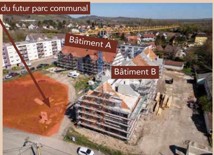
Les travaux se poursuivent : le premier bâtiment est désormais couvert.
