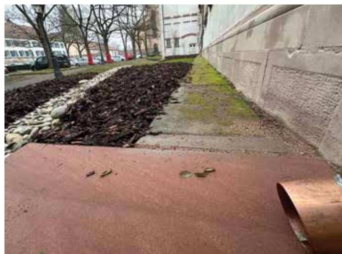
Une pente douce a été créée le long du lycée Camille Schneider au parking Kellermann pour assurer l'infiltration des eaux de pluie. Des copeaux ont été répandus pour couvrir les gaines géotextiles. Enfin quelques plantations ont été effectuées.
