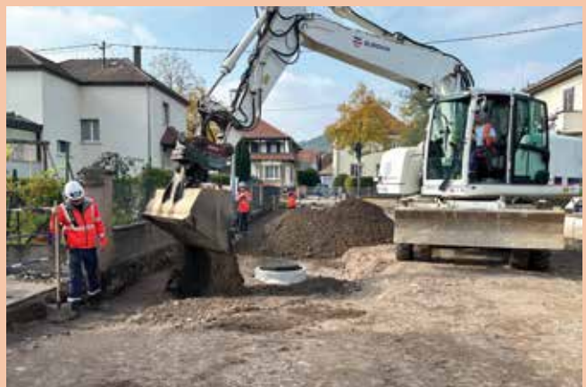
Quand la tranchée est installée, l'entreprise procède au remblaiement avant la phase ultime de pose des enrobés qui sera effectuée en toute fin de chantier.
