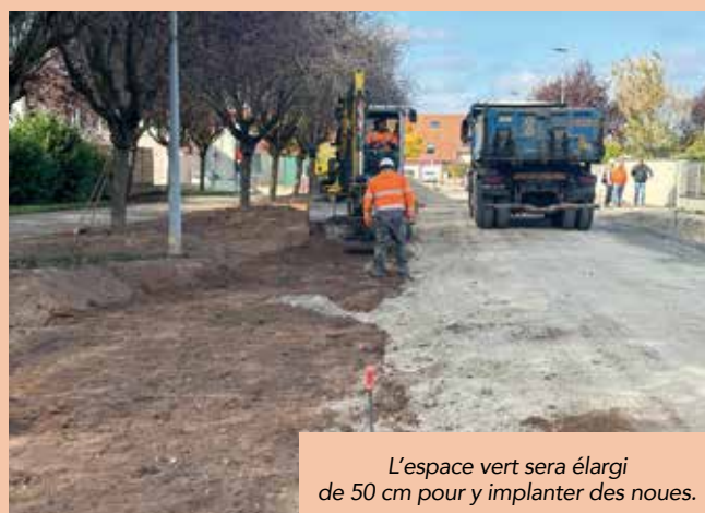
Le chantier de la rue d'Alsace a démarré le lundi 6 octobre.
