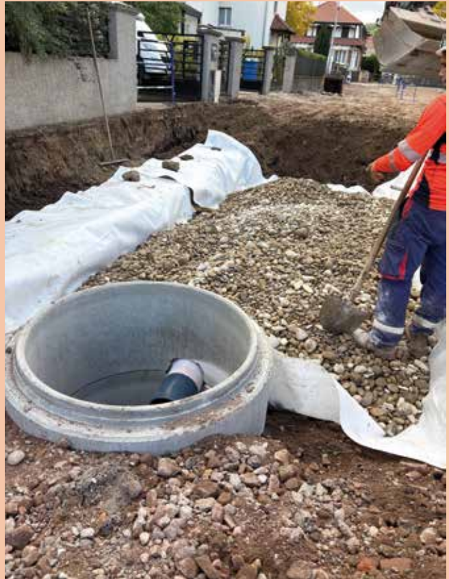
Sur cette tranchée drainante, on remarque la gaine géotextile ainsi que les matériaux granulaires. L'installation du drain permet de restituer l'eau pluviale à la nappe phréatique.
