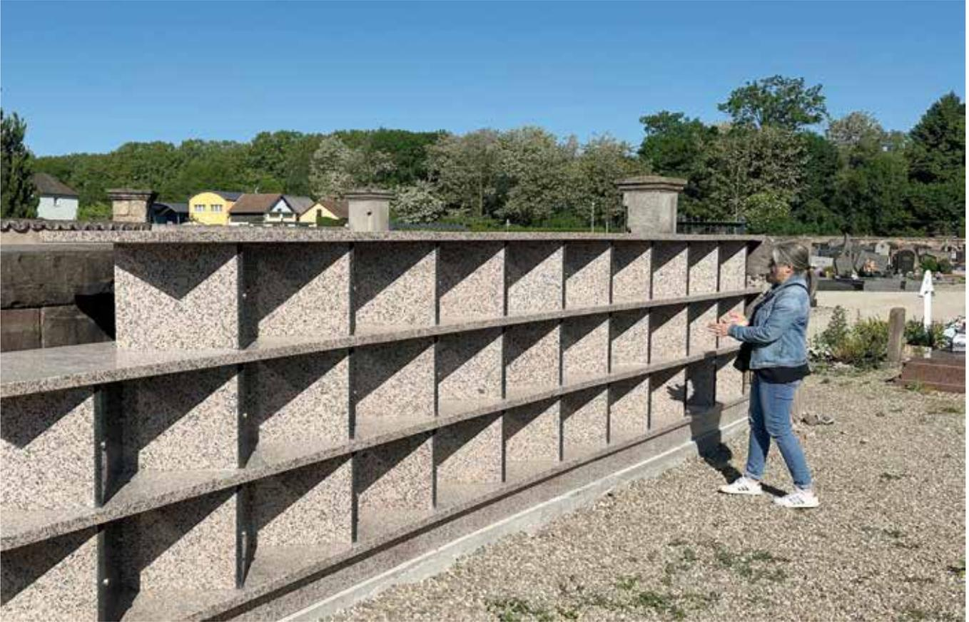
*Un espace columbarium est mis à la disposition des familles au cimetière de la route de Dachstein pour leur permettre d'y déposer trois urnes cinéraires de format standard dans chacune des 33 cases. Les portes sont vissées et une petite plate-forme extérieure permet de recueillir les arrangements floraux devant chaque case.*
