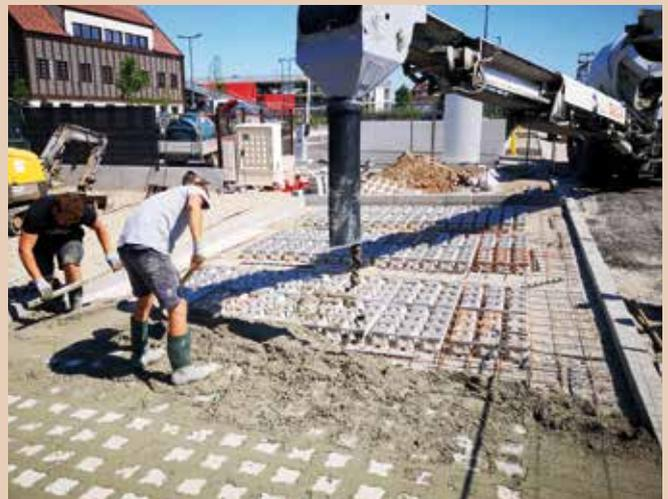
Fin juin, des aires de stationnement ont été réalisées en béton alvéolaire pour permettre l'infiltration des eaux de pluie.
