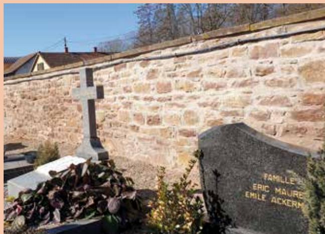
*Les joints des murs intérieurs du cimetière de la route de Dachstein sont en cours de rénovation par l'entreprise Scherberich.*
