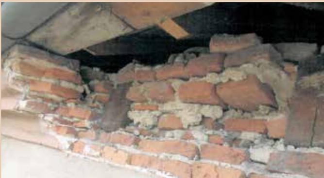
*Des éléments de maçonnerie de la corniche se révèlent être défectueux. Le montant estimatif des travaux s'établit à 133 000 € TTC.*
