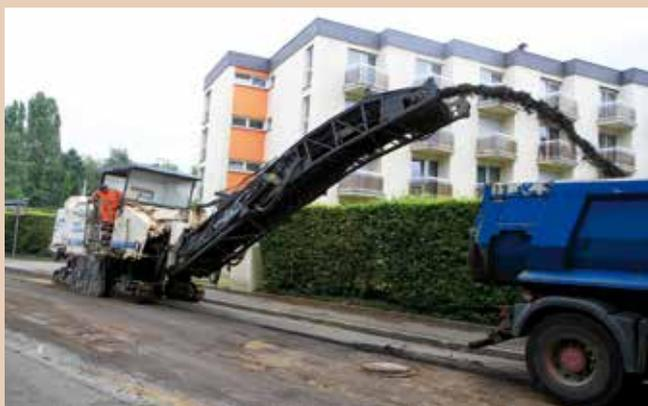
*Un rabotage des zones dégradées de la chaussée a été effectué avant la pose d'un enrobé neuf.*
