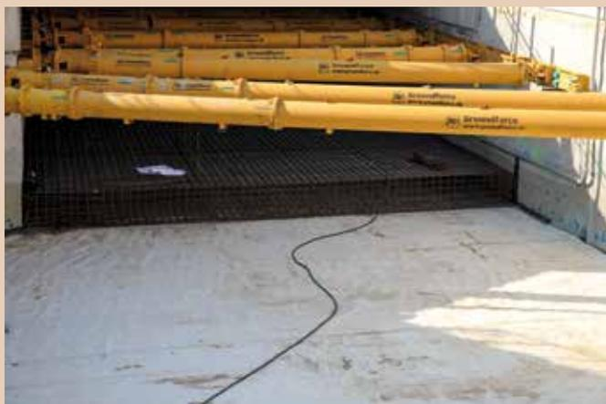
Avant bétonnage des radiers (future plateforme d'assise de la route), il a fallu isoler la dalle et réaliser l'armature métallique avec des barres de fer de plusieurs mètres de long.
