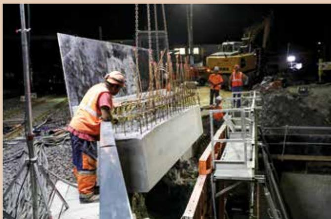
Les travaux réalisés dans la nuit du 5 au 6 septembre ont permis d'installer des pièces préfabriquées sur la paroi moulée située côté voie A.
