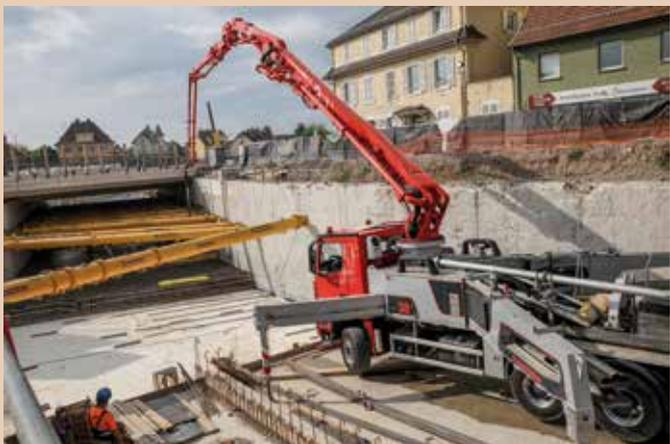
Les butons, structures métalliques de forme cylindrique, ont été déplacés côté Nord et le passage souterrain a été bétonné début septembre.
