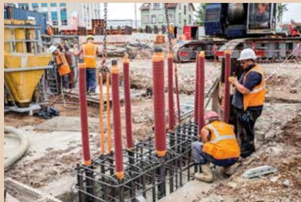
La période estivale a principalement été consacrée à la pose de parois moulées côté Sud. Après excavation à l'aide d'une benne hydraulique, les cages d'armature d'une hauteur de près de 14 m sont mises en place dans la tranchée remplie de boue-bentonite et le bétonnage du panneau est réalisé grâce à des tubes-plongeurs (Photos Passion photo club).
