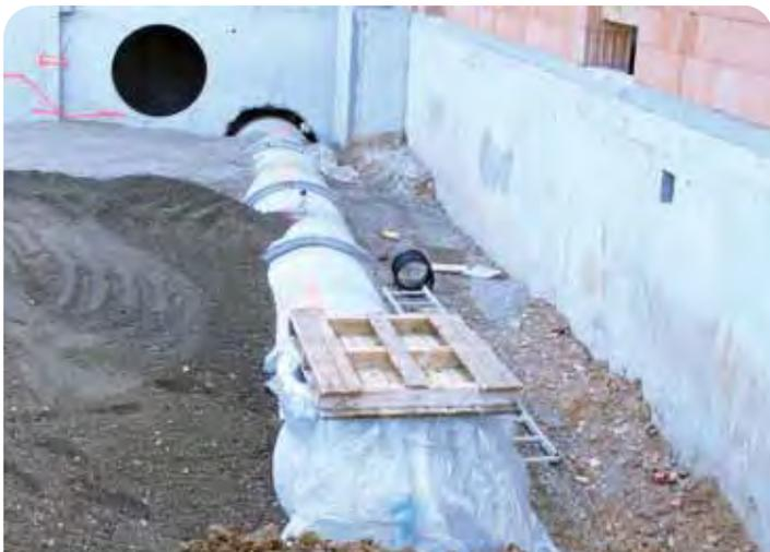
Sur le site du Krummbruchel, le réseau de gaines enfouies dans le sol permet de réchauffer ou de refroidir l'air ambiant.
