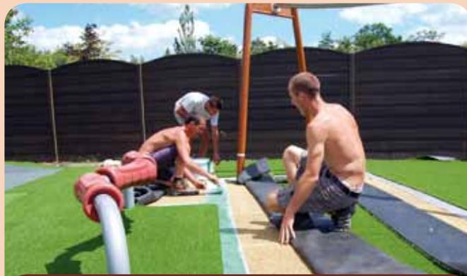
*Les ouvriers apposent le gazon synthétique sur la sous-couche "ProPlay", idéale pour réaliser des surfaces de sécurité. Amortissante, elle assure également un excellent moyen de drainage.*
