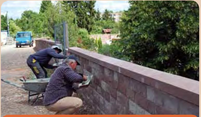
*Le mur de soutènement a été habillé par un parement en grès et chapeauté par une couvertine.*
