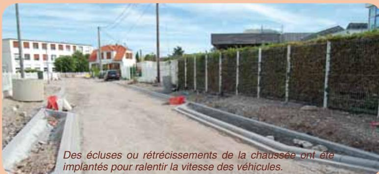
*Des écluses ou rétrécissements de la chaussée ont été implantés pour ralentir la vitesse des véhicules.*
