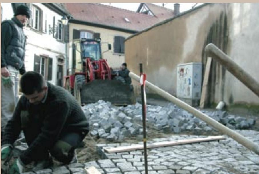
**A** lors que le renforcement des réseaux d'assainissement et d'eau potable a pris fin au mois de décembre, la rue de l'Eglise dispose à présent d'un revêtement de chaussée en pavés de granit. Ces travaux de pavage se sont terminés au début du mois de mars. Le chantier a été assuré par l'entreprise Euro-
