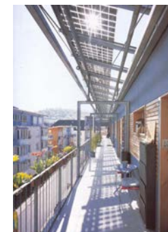
Les capteurs peuvent être utilisés comme des auvents
