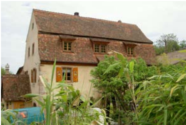
Toiture brisée à l' « alsacienne »
