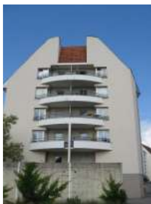
Collectifs rue Ernest Friederich (6 niveaux droits + combles)
