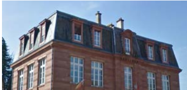
Toiture à la Mansart avec brisis et toiture ou terrasson.
