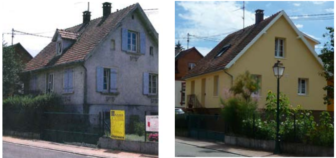
Avant Après travaux d'isolation Perte du rôle thermique des volets battants en bois suite à la pose d'une isolation thermique extérieure.
