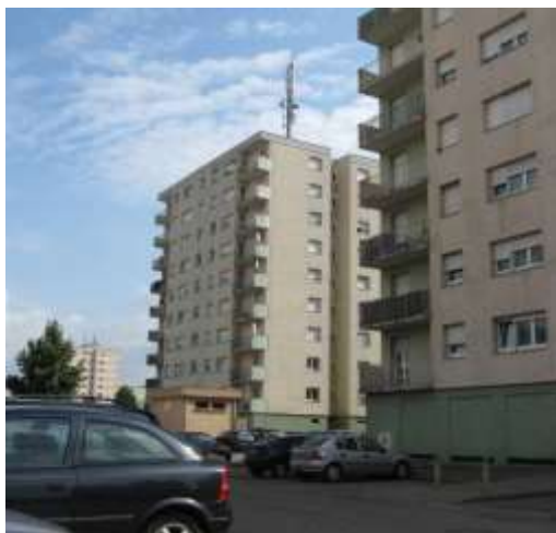
Tours de logements sociaux, Rue Henri Meck
