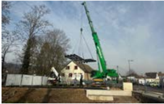
Mise en place de la passerelle cyclable rue Henri Meck
