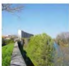
5° Assurer la défense contre les inondations et contre la mer
