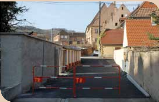
Une demi-barrière pivotante va être installée pour prioriser l'accès aux piétons et aux cyclistes.
