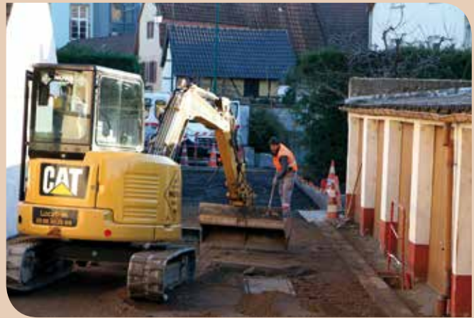
Le montant total de cet aménagement s'élève à 35 000 € TTC. La Ville prévoit également d'installer un mât d'éclairage pour sécuriser le passage.
