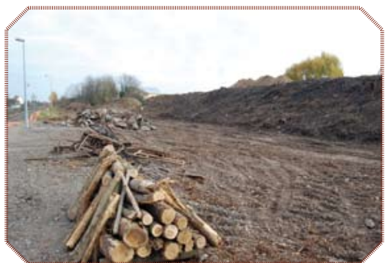
Après débroussaillage et nivellement...
