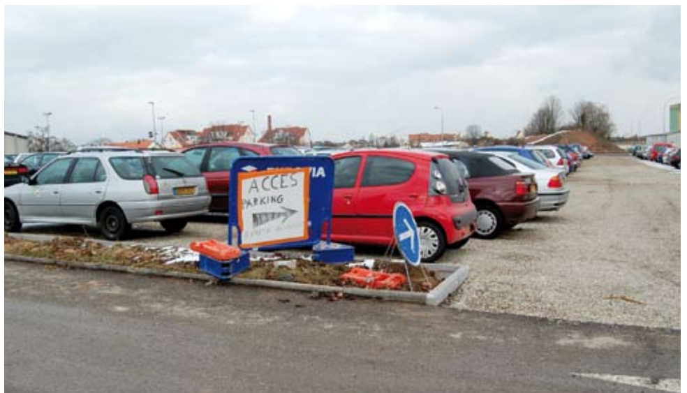
La nouvelle aire de stationnement est ouverte aux véhicules légers pendant les travaux de réaménagement du parking existant. Un portique limiteur de hauteur n'autorisera l'accès au parking qu'aux véhicules légers.
