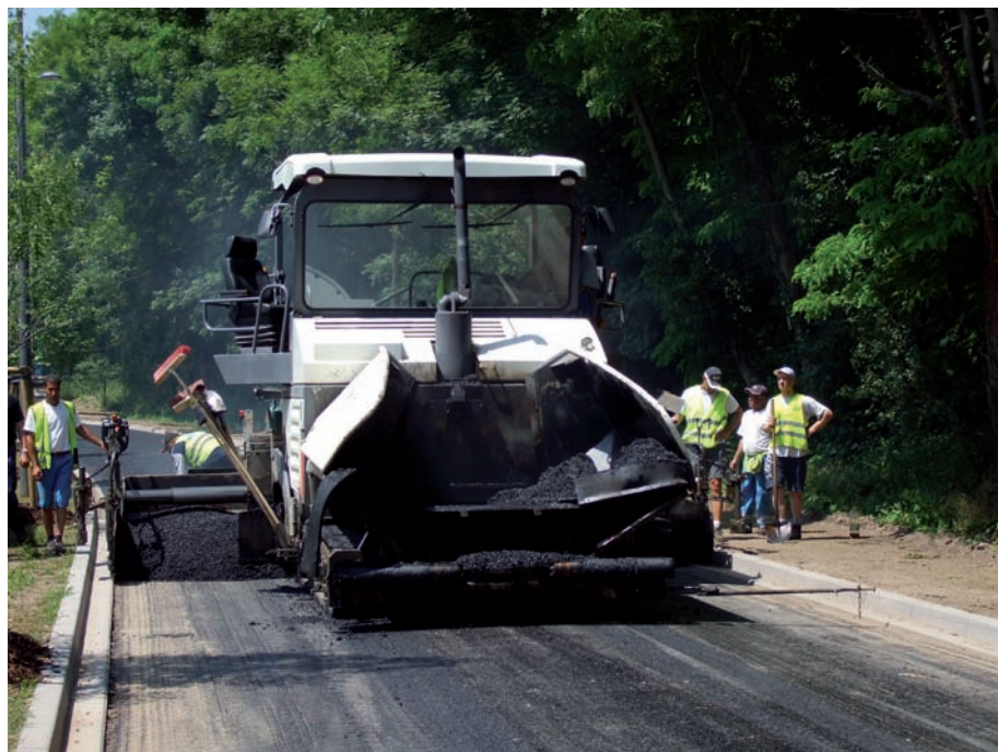
Côté Molsheim, la chaussée a été revêtue d'un tapis de béton bitumeux en juin 2008
