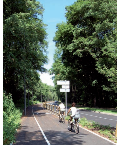
La piste cyclable et l'espace piéton sont séparés du trafic routier par une bande d'espaces verts ou par une barrière bois.
