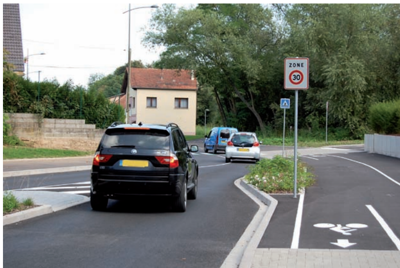
A l'entrée de la ville de Molsheim, une chicane et une réduction de chaussée contraignent les automobilistes à respecter la vitesse imposée de 30 km/h.
