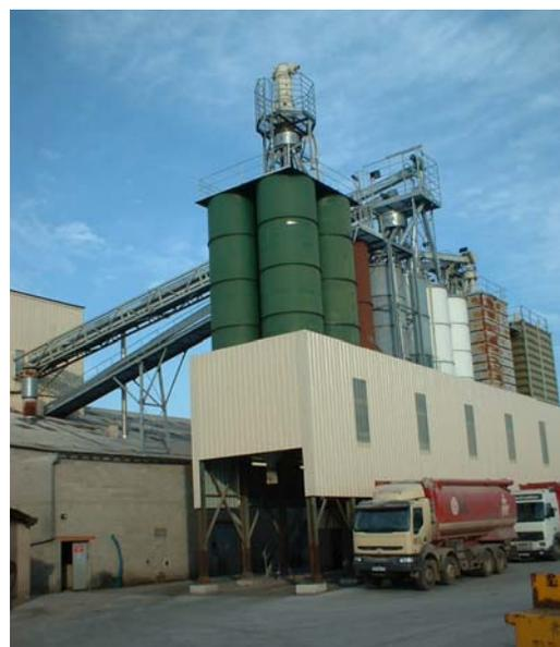
tonnage : une voirie béton est venue l'entourer, une benne peseuse supplémentaire a remplacé l'ancien séchoir à maïs, l'automatisation accompagne tous les mouvements de matière et accélère les process de fabrication, une nouvelle presse a été installée en 2006. Rien n'est figé, et tout est régulièrement remis en cause pour s'adapter aux évolutions du marché.
